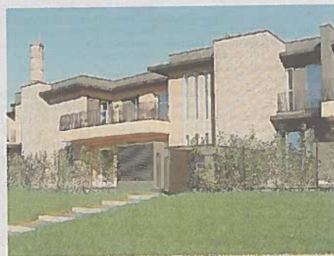
ALL'AVANGUARDIA Il complesso residenziale e commerciale è situato accanto all'ex Fornace, in via dei Novale
